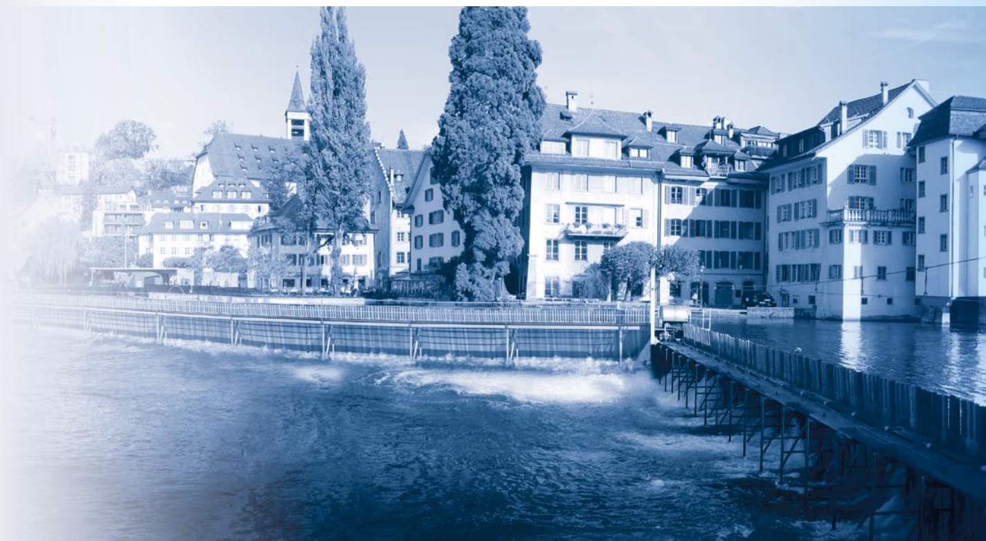
Fotomontage: Sicht auf das Nadelwehr bei geringem Abfluss in der Reuss, links das neue Längsnadelwehr, rechts das Stirnadelwehr, das in seiner Lage und Konstruktionsart unverändert bleibt.
