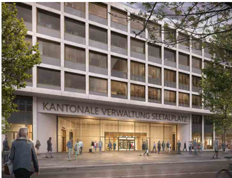
Haupteingang des Verwaltungsgebäudes am Busbahnhof
