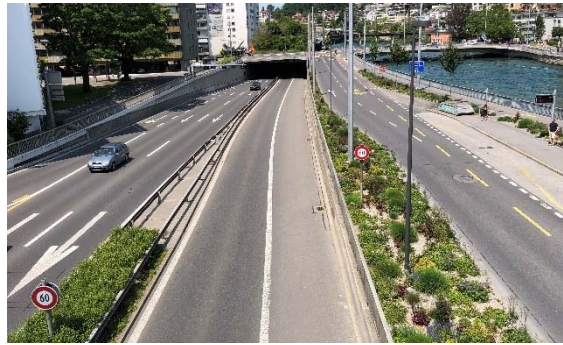
Abb. 27: Einfahrtsrampe Stadtautobahn (Blickrichtung Autobahn)
